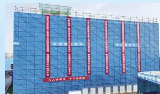
高科·智造园建设实景图
