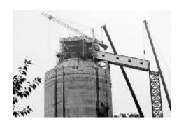
阳光讯(记者 史超 通讯员 穆海宏 文/图) 近日,在延安市重点工程项目黄陵矿业双龙 煤业储煤设施改造项目施工现场,随着现场 负责人的有序指挥,重150吨的栈桥缓缓离开 地面,被吊至61米高空开始安装作业。
