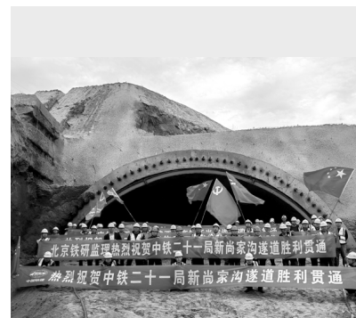
↑西延高铁新尚家沟隧道顺利贯通
